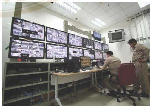
รูปที่ 5 การตรวจสอบความปลอดภัย
